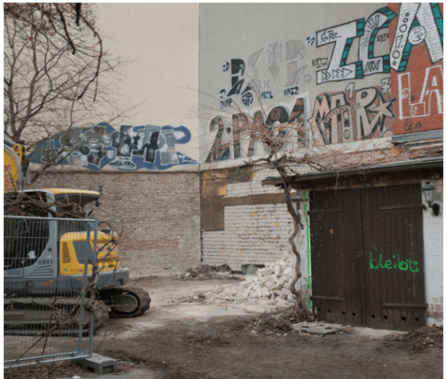
Abrissbeginn im Innenhof der K10.
