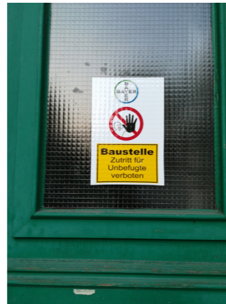
Die letzte Mietpartei der Tegeler Straße 4 ist kürzlich ausgezogen, jetzt wird bereits entkernt.
